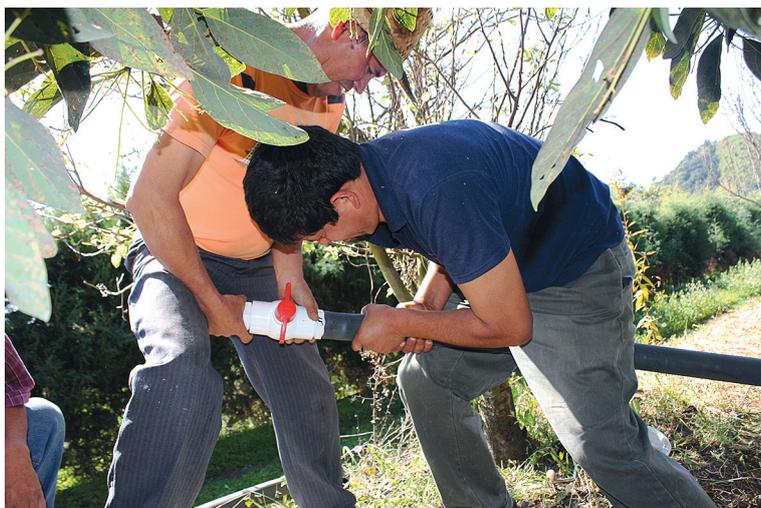
**Foto 122.** Colocando la válvula de desfogue.
