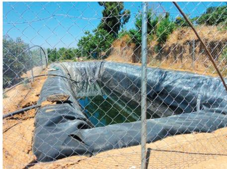
**Foto 37.** Hoya cubierta por membrana impermeable, plástica preformada.
