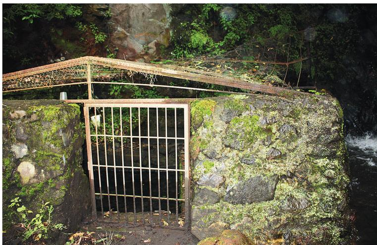
**Foto 109.** Caja de captación de agua en lecho del río Amatzinac.
