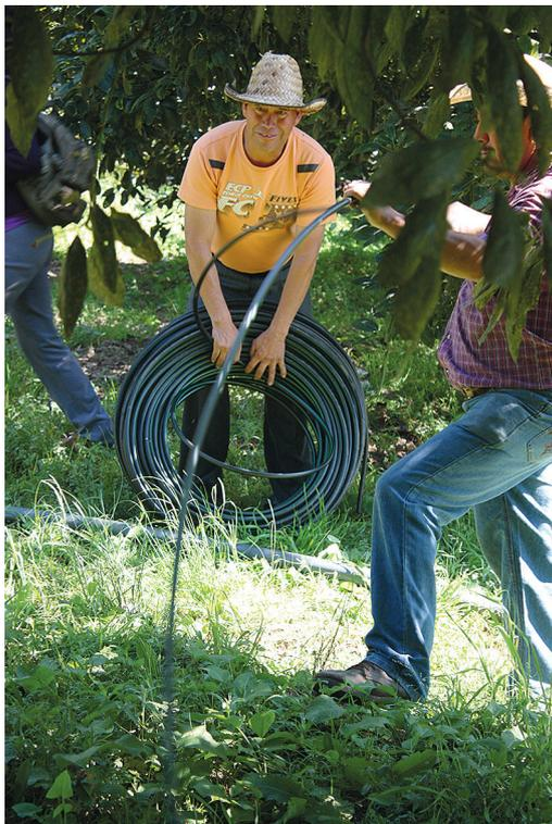
**Foto 121.** Colocación de mangueras secundarias.
