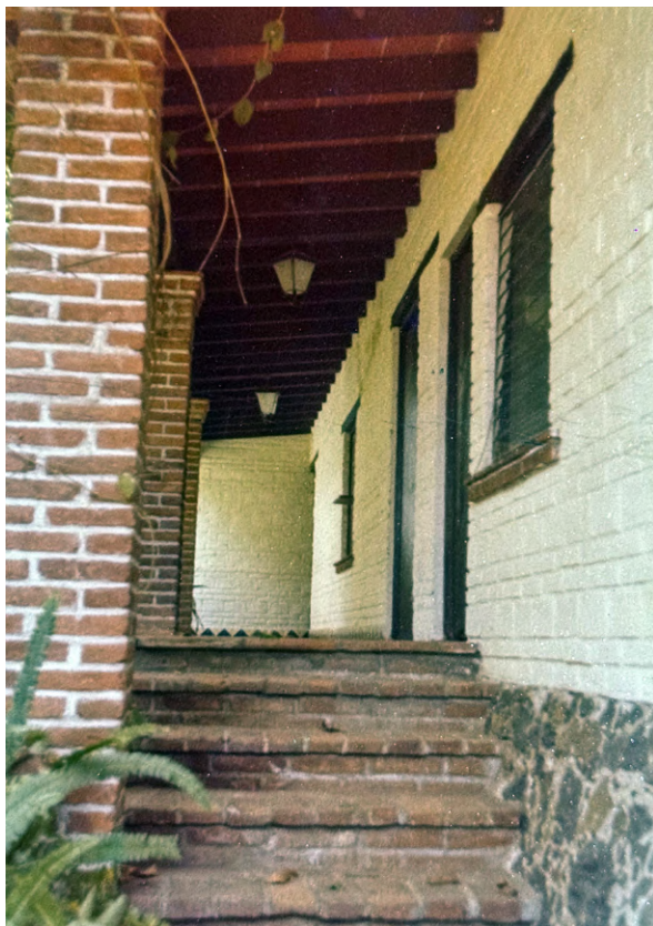
Figura 60. Módulo de habitaciones demolidas en el año 2014 para dar paso a nuevos proyectos en el Centro Universitario Los Belenes. Fotografía: VGT.
