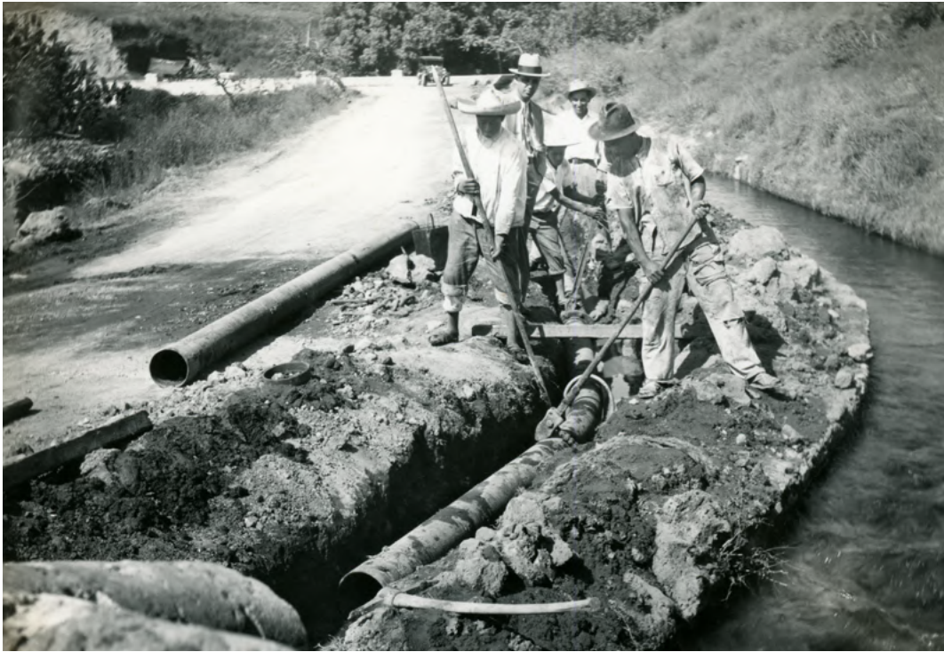
Figura 22. Trabajadores en la instalación de la red hidráulica aledaña al club de golf. Archivo VEC. Fotografos de prensa, 1932.
