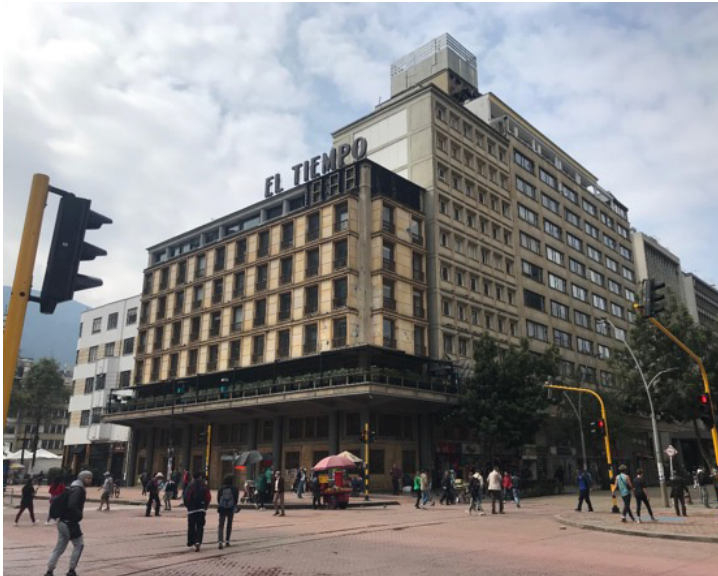
Figura 13. Edificio para el diario El Tiempo, ubicado en el predio en el que se encontraba el Edificio de Coltabaco, costado suroriental de la esquina
