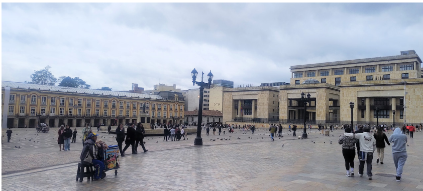
Figura 3. Diseño actual de la Plaza de Bolívar: Alcaldía Mayor de Bogotá D. C. (izquierda); nuevo Palacio de Justicia Alfonso Reyes Echandía (derecha)
