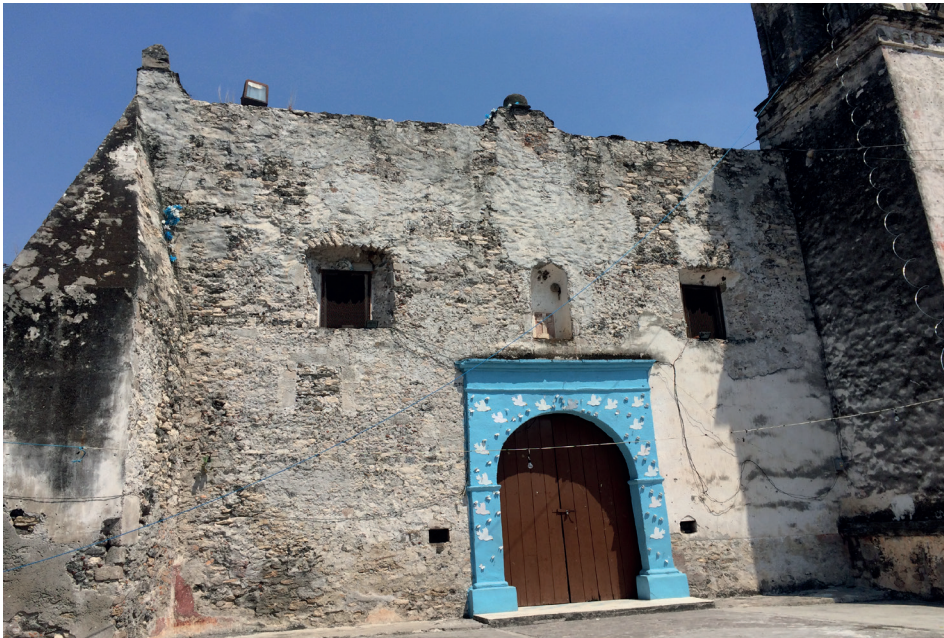
Figura 1. Fachada de la capilla.
