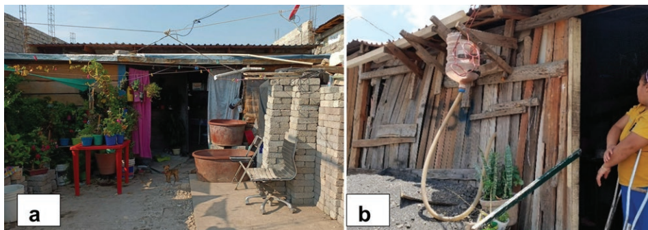
Figura 3. Viviendas con sistemas de captación de agua pluvial
